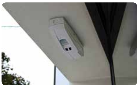
Montaggio orizzontale sull'architrave
